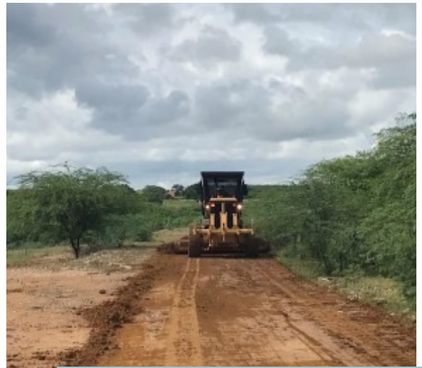
Motoniveladora em atividade de manutenção de estrada de serviço do segmento de canal WBS 1220, Trecho II, Eixo Norte.
