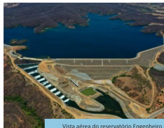
Vista aérea do reservatório Engenheiro Hilton Temóteo (WBS 1111), Jati-CE, Trecho I, Eixo Norte.
