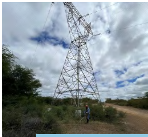
Limpeza manual na base da Torre 49/2 da LT, próximo do segmento de canal WBS 2210, Trecho V do Eixo Leste do PISF, em Floresta/PE (out/2025).).
