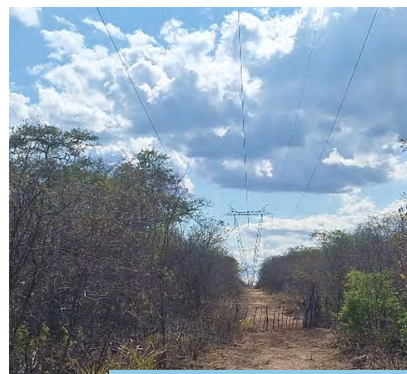
Vista da faixa de servidão da LT, próximo do reservatório Moxotó (WBS 2112), Trecho V do Eixo Leste do PISF, em Sertânia/PE (out/2025).
