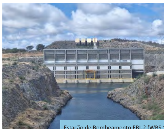
Estação de Bombeamento EBI-2 (WBS 1620), Trecho I, Eixo Norte do PISF, em Cabrobó/PE.
