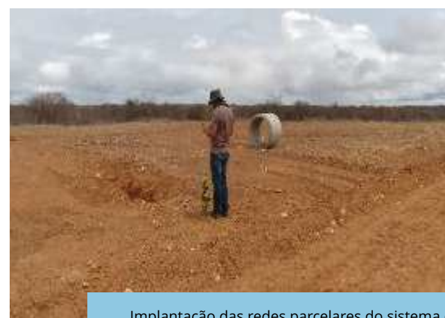
Implantação das redes parcelares do sistema de irrigação da VPR Captação, Cabrobó - PE.
