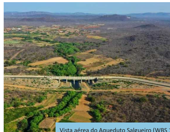
Vista aérea do Aqueduto Salgueiro (WBS 1309), Salgueiro-PE, Trecho I, Eixo Norte.
