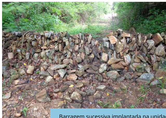
Barragem sucessiva implantada na unidade demonstrativa da VPR Quixeramobim, Trecho II, Eixo Norte do PISF
