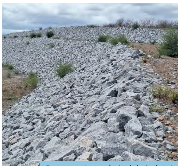
Enrocamento de proteção de taludes implantado, no segmento de canal WBS, Trecho V, Eixo Leste do PISF (set/2025).
