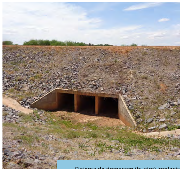
Sistema de drenagem (bueiro) implantado no segmento de canal WBS 1232, Trecho II, Eixo Norte do PISF (set/2025).
