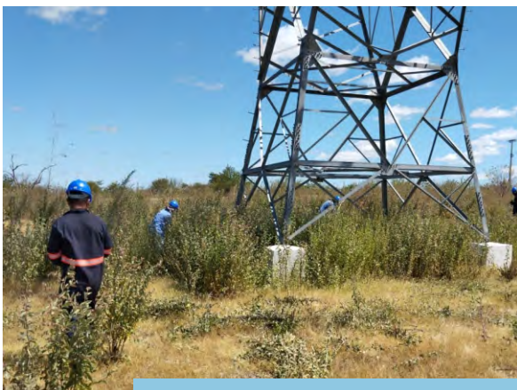
Manutenção e limpeza na faixa de servidão da linha de transmissão, próximo ao segmento de canal WBS 2620, do Eixo Leste do PISF.
