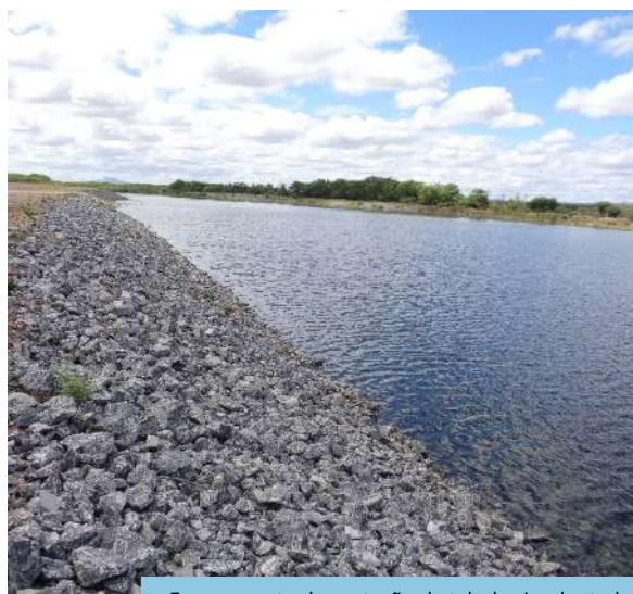
Enrocamento de proteção de taludes implantado no segmento de canal WBS 2204 (canal de aproximação), Trecho V, Eixo Leste do PISF.
