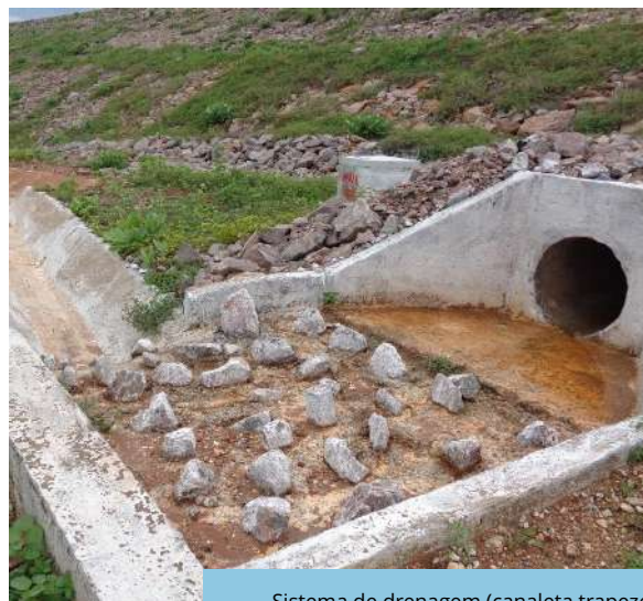
Sistema de drenagem (canaleta trapezoidal e bueiro) implantado no segmento de canal WBS 1117, Trecho II, Eixo Norte do PISF.
