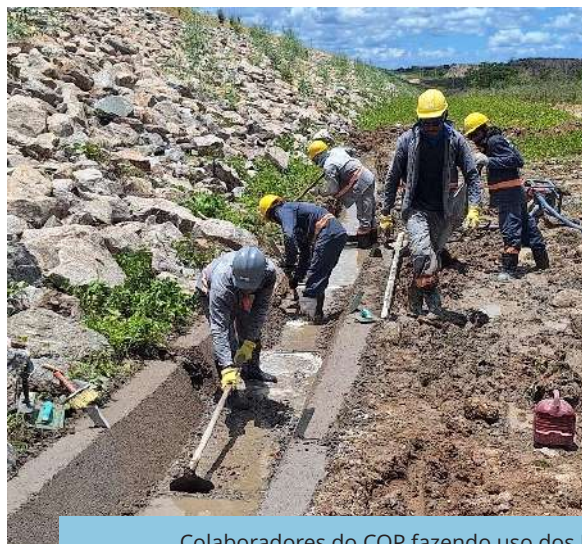
Colaboradores do COP fazendo uso dos EPIs adequados, durante execução de canaletas a jusante do reservatório Salgueiro (WBS 2107), Trecho V, Eixo Leste do PISF.
