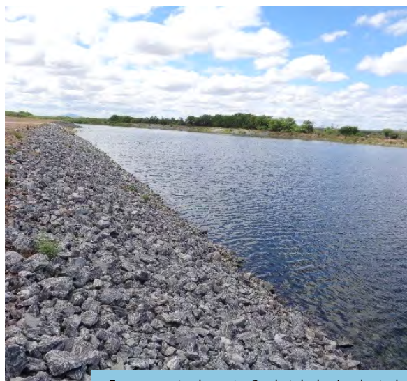
Enrocamento de proteção de taludes implantado no segmento de canal WBS 2204 (canal de aproximação), Trecho V, Eixo Leste do PISF (maio/2025).
