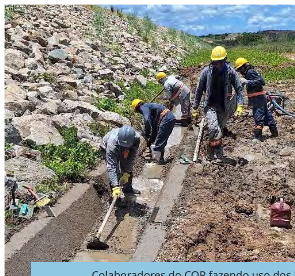
Colaboradores do COP fazendo uso dos EPIs adequados, durante execução de canaletas a jusante do reservatório Salgueiro (WBS 2107), Trecho V, Eixo Leste do PISF (maio/2025).
