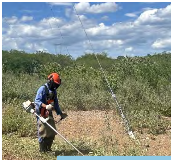
Limpeza semimecanizada na base da torre da LT, próximo do segmento de canal WBS 2218, Trecho V do Eixo Leste do PISF, em Custódia/PE (abr/2025).
