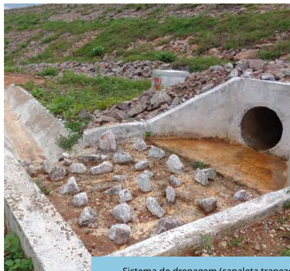
Sistema de drenagem (canaleta trapezoidal e bueiro) implantado no segmento de canal WBS 1117, Trecho II, Eixo Norte do PISF (maio/2025).
