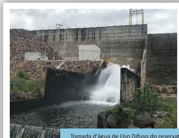
Tomada d'água de Uso Difuso do reservatório Porcos, WBS 1113, Trecho II, Eixo Norte do PISF.
