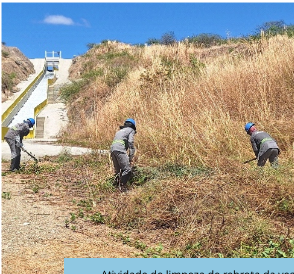
Atividade de limpeza de rebrota da vegetação no entorno do vertedouro Rápido (WBS 1382), Trecho II, Eixo Norte do PISF (dez/2025).
