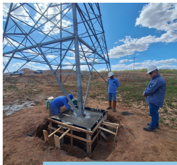
Reforço em estrutura da LT, localizada no entorno do segmento de canal WBS 2212, Trecho V do Eixo Leste do PISF, em Floresta/PE (jan/2026).
