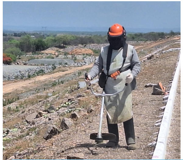
Colaborador do Consórcio Operador em atividade de limpeza de rebota em barragem do reservatório Cipó (WBS 1115), Trecho II, Eixo Norte do PISF (jan/2026).
