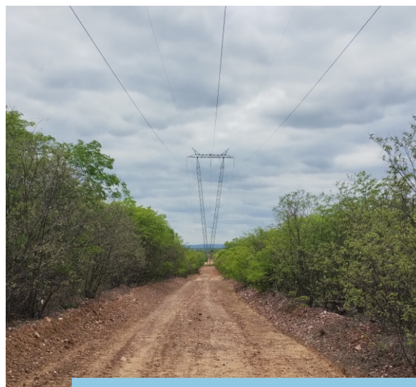
Faixa de servidão da LT após limpeza de rebrota da vegetação, nas proximidades do reservatório Mangueira (WBS 1108), Trecho I do Eixo Norte do PISF, em Salgueiro/PE (jan/2026).
