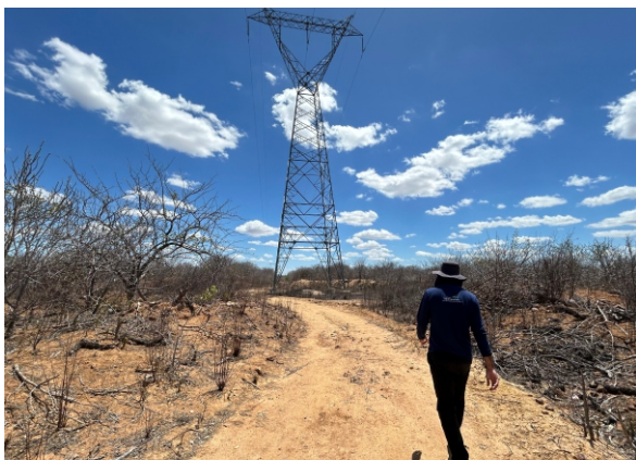
Faixa de servidão da linha de transmissão, próximo ao reservatório Salgueiro - WBS 2107, do Eixo Leste do PISF (jan/2026).
