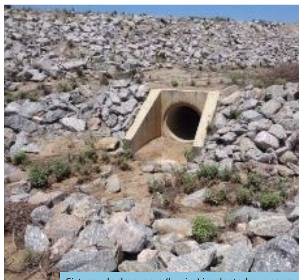
Sistema de drenagem (bueiro) implantado no segmento de canal WBS 2208, Trecho V, Eixo Leste do PISF (dez/2025).
