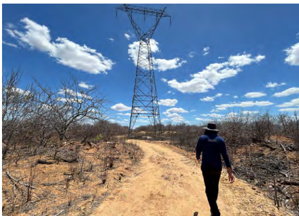
Faixa de servidão da linha de transmissão, próximo ao reservatório Salgueiro - WBS 2107, do Eixo Leste do PISF (jan/2026).
