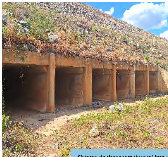
Sistema de drenagem (bueiro) implantado no segmento de canal WBS 1229, Trecho II, Eixo Norte do PISF (dez/2025).
