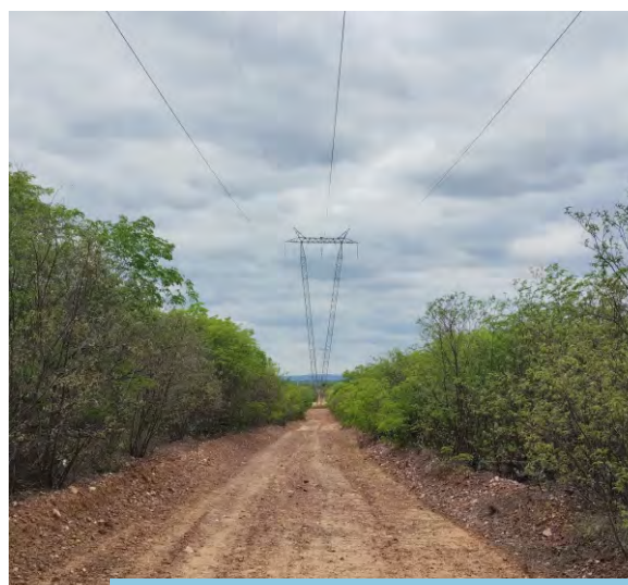
Faixa de servidão da LT após limpeza de rebrota da vegetação, nas proximidades do reservatório Mangueira (WBS 1108), Trecho I do Eixo Norte do PISF, em Salgueiro/PE (jan/2026).
