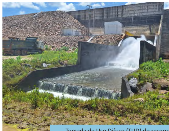
Tomada de Uso Difuso (TUD) do reservatório Porcos (WBS 1113), Brejo Santo/CE - Trecho II, Eixo Norte do PISF (jan/2026).
