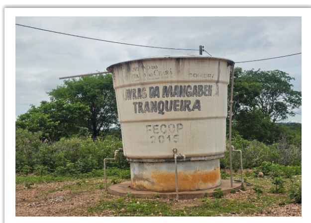
Caixa d'água do Sistema de Abastecimento de Água (SAA) localizada no Sítio Tranqueira, município de Lavras da Mangabeira/CE.
