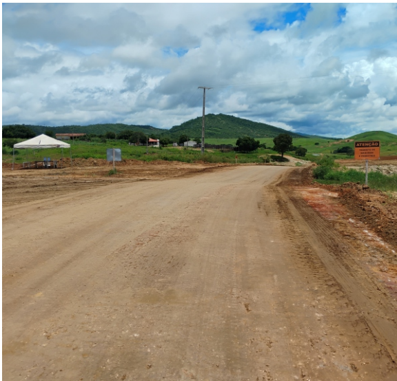
Estrada vicinal interceptada pelas obras de construção do Ramal do Salgado.
