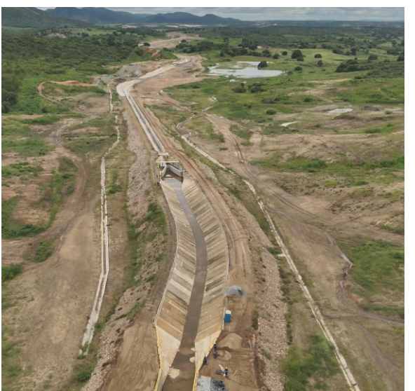
Monitoramento de áreas susceptíveis ao surgimento de processos erosivos e carreamento de sedimentos no Segmento de Canal O1, Rápido Faz. Pau Branco e Segmento de Canal O2.
