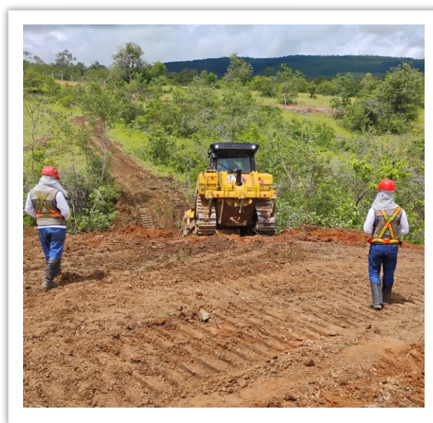
Supressão vegetal mecanizada no Segmento de Canal 09.
