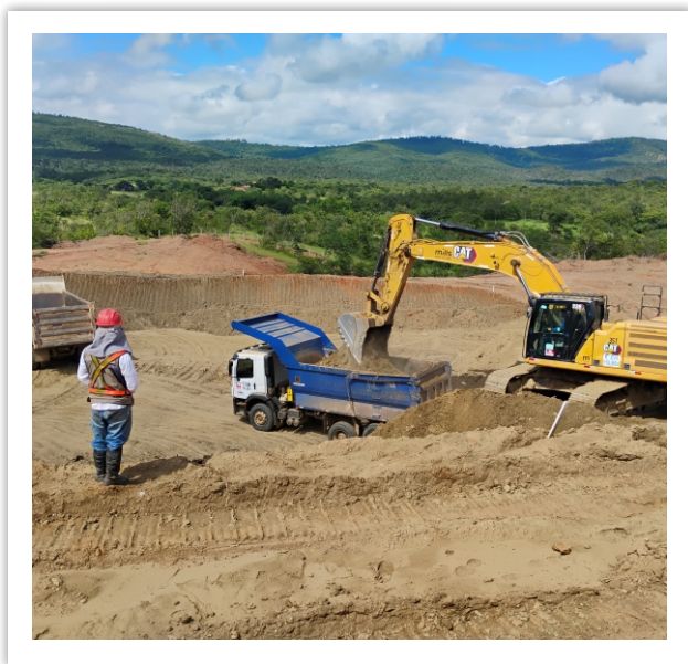
Escavação de caixa de empréstimo no Segmento de Canal 09.
