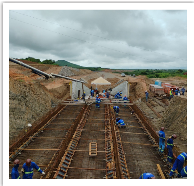
Avanço das atividades construtivas do Sifão sob a BR-116.
