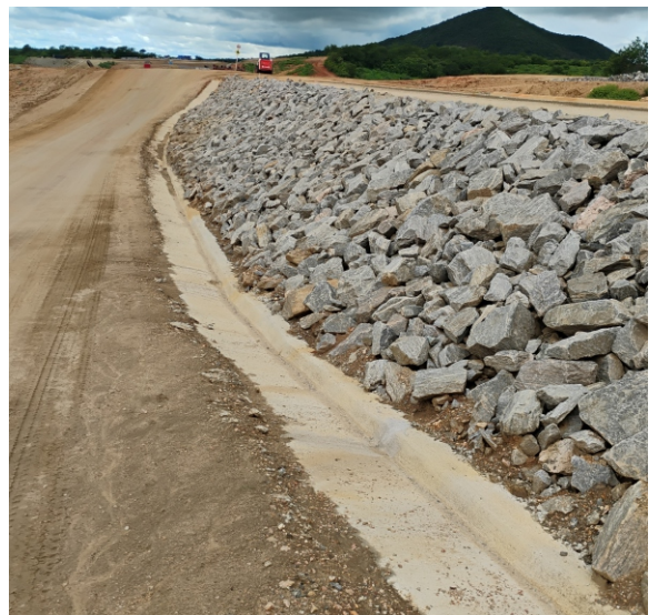
Implantação de dispositivos de proteção ao surgimento de processos erosivos em área adjacente ao Segmento de Canal O3.
