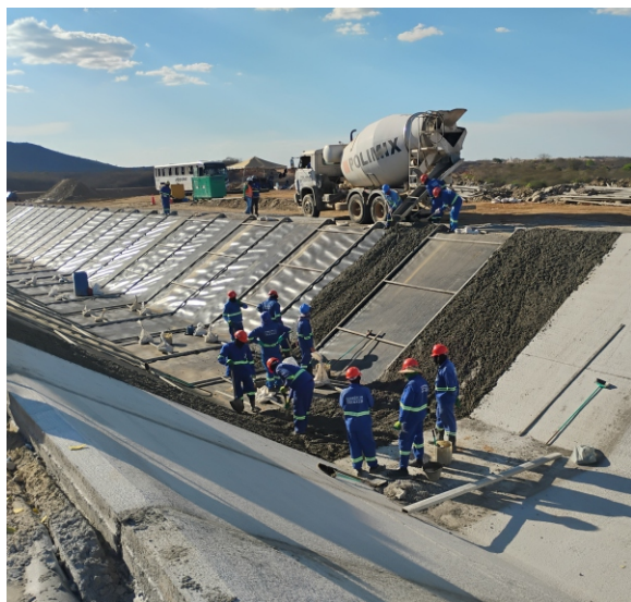
Revestimento do canal adutor no Segmento de Canal 04.
