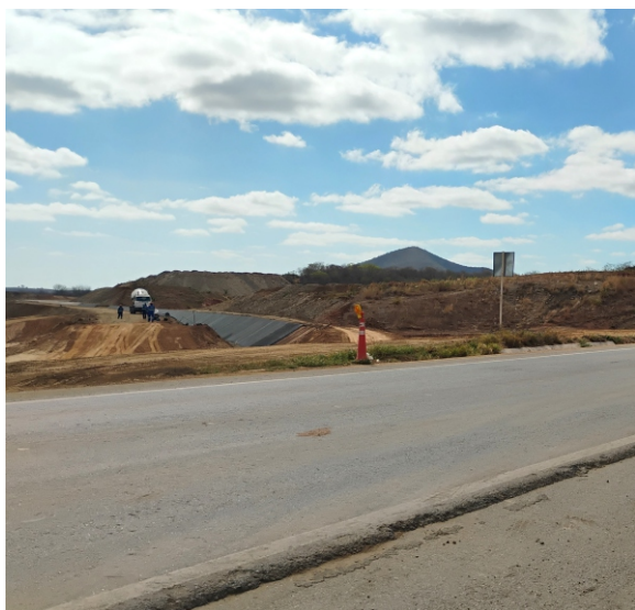
Trecho da BR-116 a ser interceptado pelas obras de construção do Ramal do Salgado.
