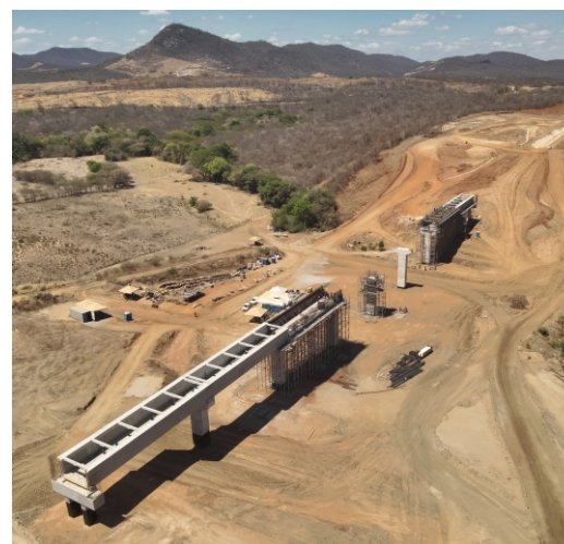
Avanço das atividades construtivas do Aqueduto Cajazeirinha.
