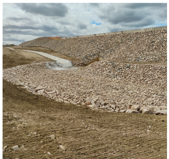
Enrocamento como medida preventiva a processos erosivos em Bueiro sob o Rápido Faz Pau Branco.
