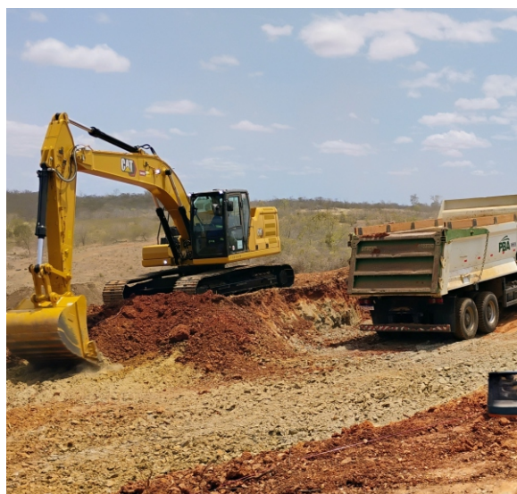
Escavação de caixa de empréstimo na faixa marginal do Túnel Saco dos Bois.
