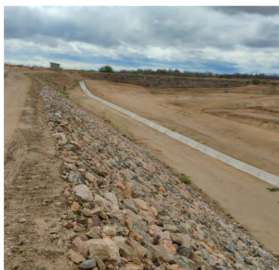
Enrocamento de talude e canaletas para direcionamento de águas pluviais como medidas protetivas ao surgimento de processos erosivos.
