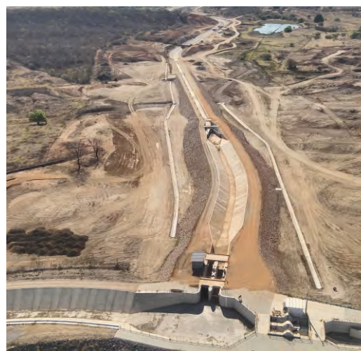
Avanço das atividades construtivas da Estrutura de Controle, Segmento de Canal 01, Rápido Faz. Pau Branco e Segmento de Canal 02.
