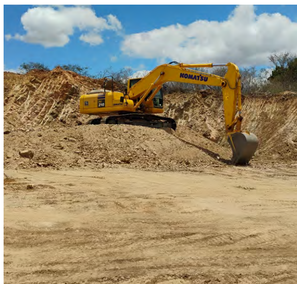
Escavação de caixa de empréstimo em faixa marginal ao Segmento de Canal 03.
