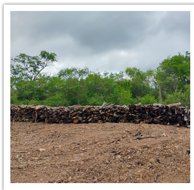
Material lenhoso enleirado às margens do Segmento de Canal 09.
