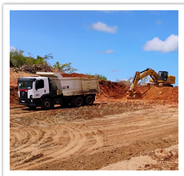
Escavação de caixa de empréstimo no Segmento de Canal 08.
