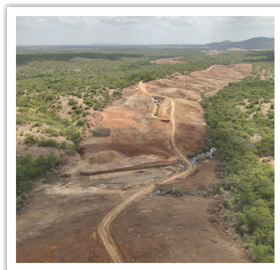
Avanço das atividades construtivas no Rápido Porteiros e Segmento de Canal 08.
