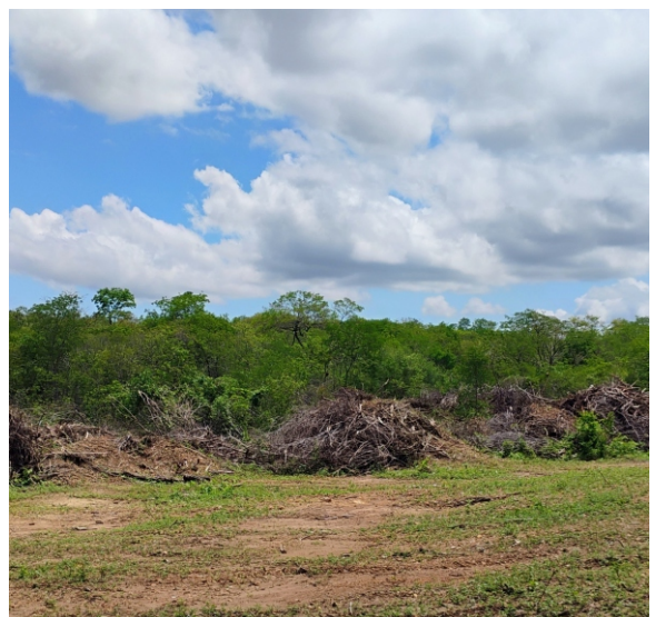
Material orgânico armazenado no Segmento de Canal 08.
