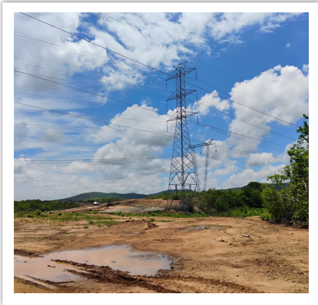
Rede elétrica interceptada pelas obras de construção do Ramal do Salgado.
