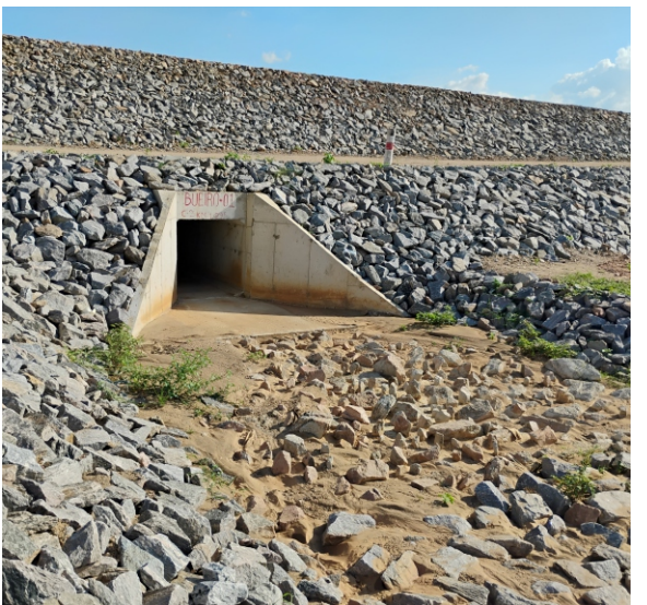
Implantação de medidas protetivas ao surgimento de processos erosivos (enrocamento do canal de restituição para direcionamento de águas pluviais) em área adjacente ao Segmento de Canal 02.
