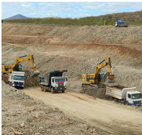
Escavação do emboque do Túnel Saco dos Bois.
