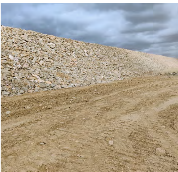
Enrocamento como medida preventiva a processos erosivos no aterro do Segmento de Canal 02.
