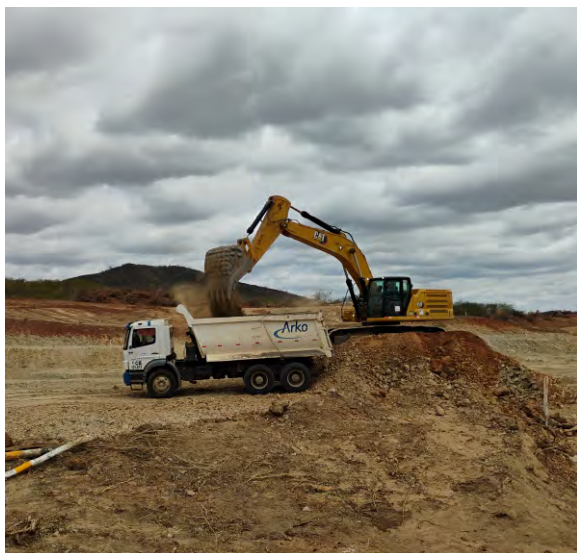
Escavação de caixa de empréstimo no Segmento de Canal 04.
