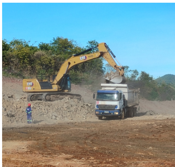
Escavação de caixa de empréstimo no Segmento de Canal 02.
