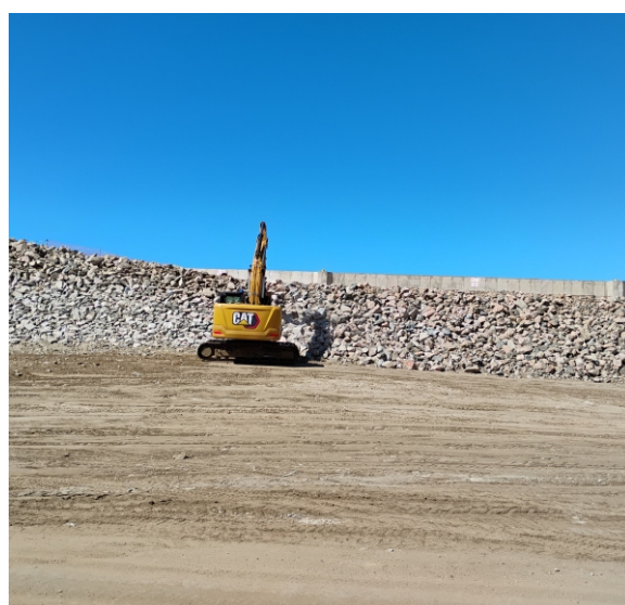
Enrocamento no talude de aterro do Rápido Faz Pau Branco.
