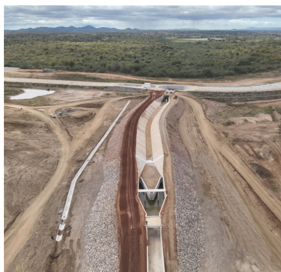
Avanço das atividades construtivas da Estrutura de Controle, Segmento de Canal 1 e Rápido Faz. Pau Branco.
