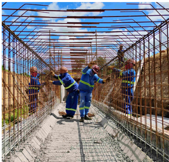
Armação de ferragens para implantação de bueiro celular no Segmento de Canal 02.
