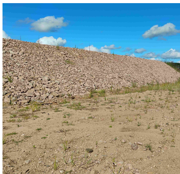
Enrocamento no talude de aterro do Segmento de Canal 01.
