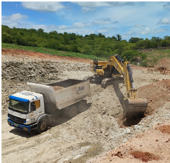
Escavação de caixa de empréstimo no Segmento de Canal 02 (WBS 3206)
