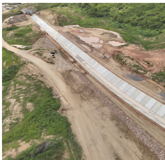
Utilização de Veículo Aéreo não Tripulado (VANT) para monitoramento dos locais susceptíveis ao surgimento de processos erosivos e carreamento de sedimentos No Segmento de Canal 02
