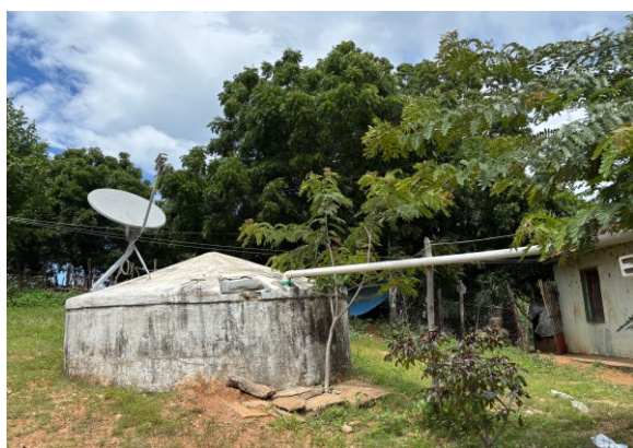
Estrutura de abastecimento (cisterna de captação de água da chuva) localizada no sítio Boi, município de Ipaumirim – CE.
