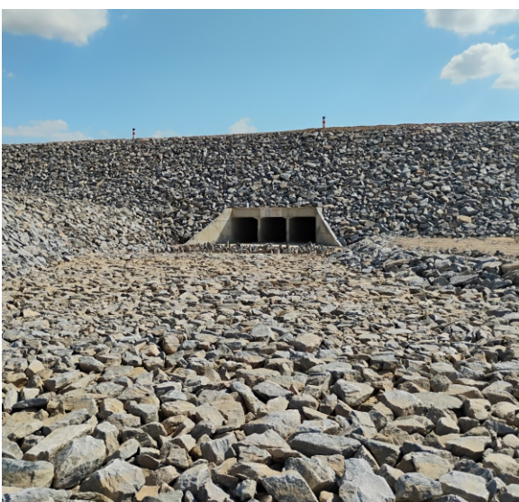
Implantação de medidas protetivas ao surgimento de processos erosivos (enrocamento do canal de restituição para direcionamento de águas pluviais) em área adjacente ao Segmento de Canal O2.
