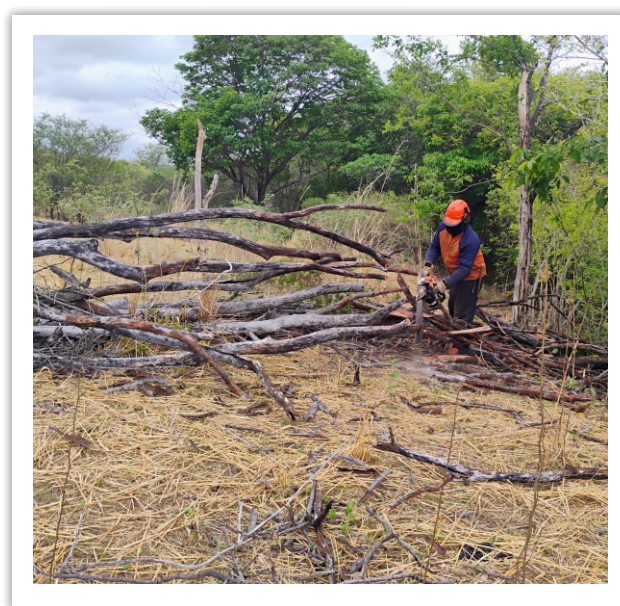
Supressão vegetal semimecanizada no Aqueduto Monte Alegre.
