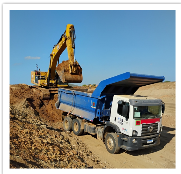
Escavação de caixa de empréstimo no Segmento de Canal 06.
