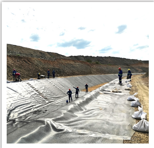
Instalação de geomembrana no canal adutor do Segmento de Canal 04.
