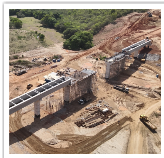
Avanço das atividades construtivas do Aqueduto Cajazeirinha.
