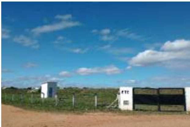
Estação de Tratamento de Esgoto de Mauriti/CE
