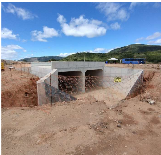
Execução de galeria no segmento de canal 2.
