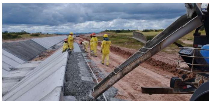
Atividade de concretagem no segmento de canal 13B.
