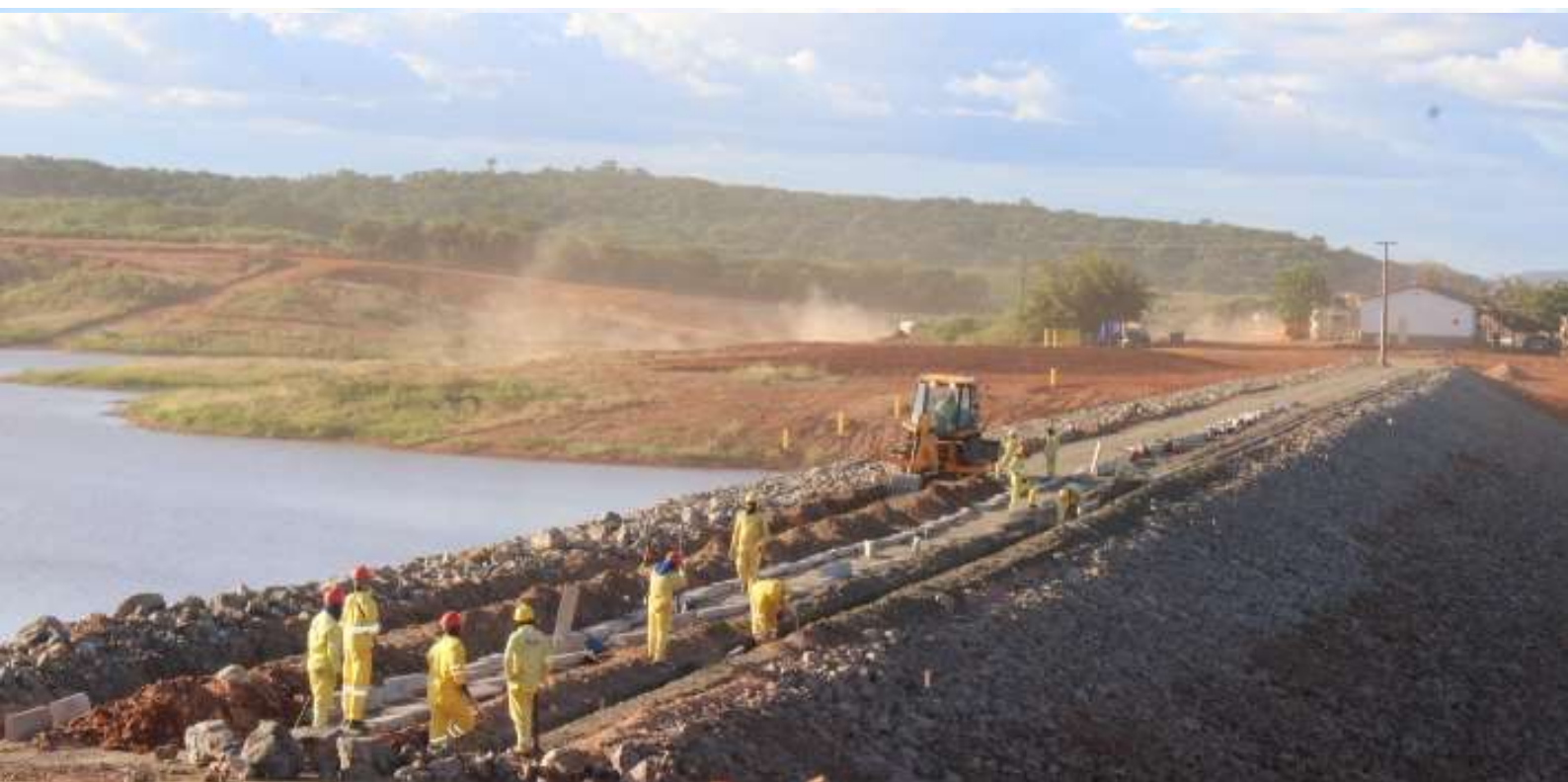
Enrocamento de talude na área do Reservatório Tambor.
