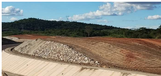
Atividade de reconformação de área localizada no segmento de canal 3.
