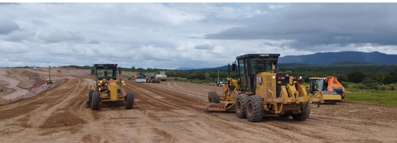
Atividade de terraplanagem no segmento de canal 13B.
