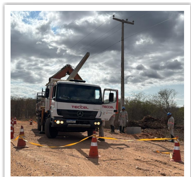
Recolocação de fibra óptica no segmento de canal 13C.
