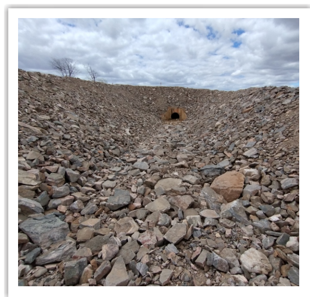
Enrocamento de proteção do canal de restituição de bueiro no segmento de canal 11, Santa Helena/PB.
