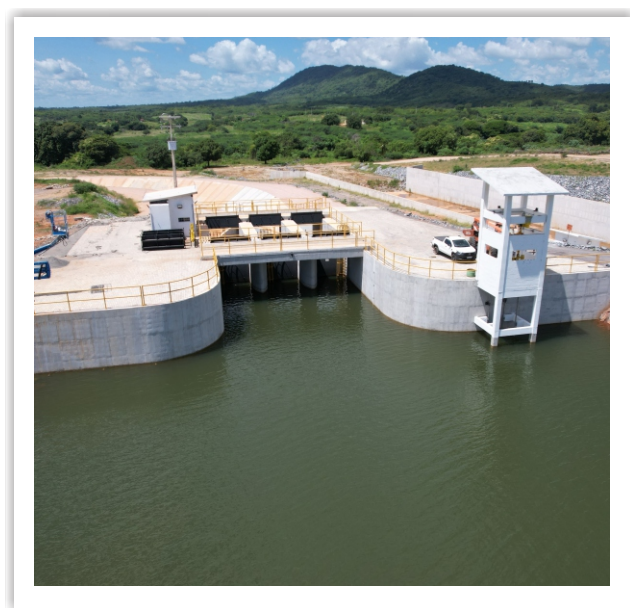
Estrutura de controle do Reservatório Redondo.
