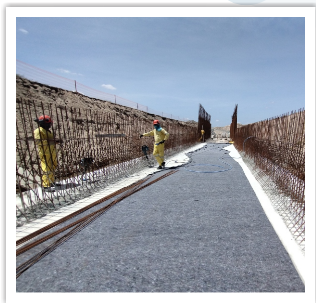
Execução da Galeria Bela Vista
