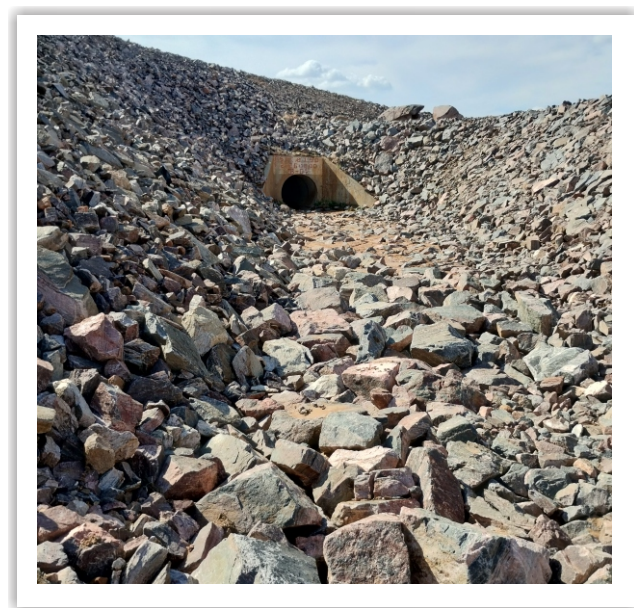
Enrocamento de proteção e canal de restituição implantados em bueiro no segmento de canal 11.
