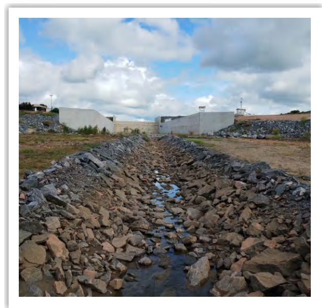
Estruturas do vertedouro com canal de restituição do reservatório Redondo.
