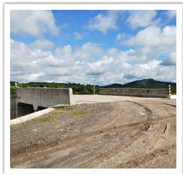
Estrutura da Galeria PA3 para manutenção do fluxo viário sobre o segmento do canal 4.
