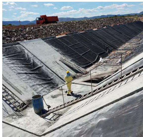
Execução do revestimento do canal com aplicação de Geomembrana.
