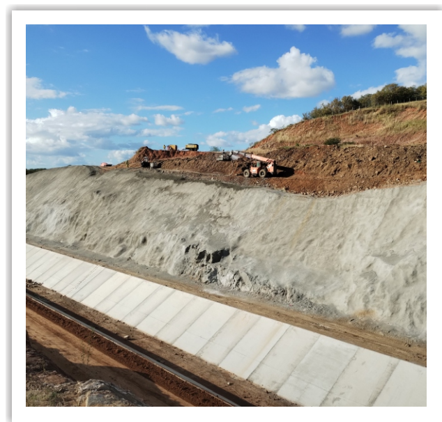
Jateamento de concreto para estabilização de talude de corte no segmento de canal 9, Santa Helena-PB.
