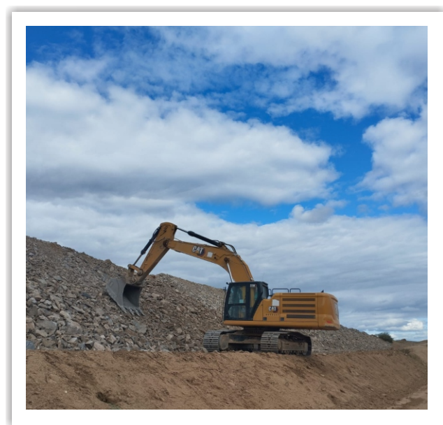
Execução do enrocamento de proteção do talude no segmento de canal 11.
