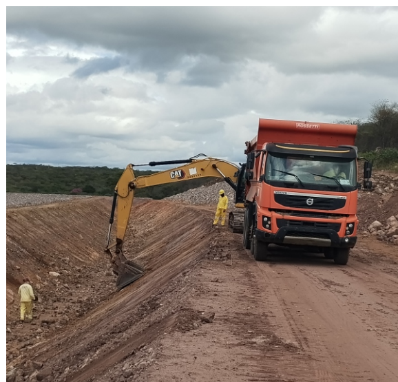
Regularização e Conformação de Talude Interno do segmento Canal 13C.
