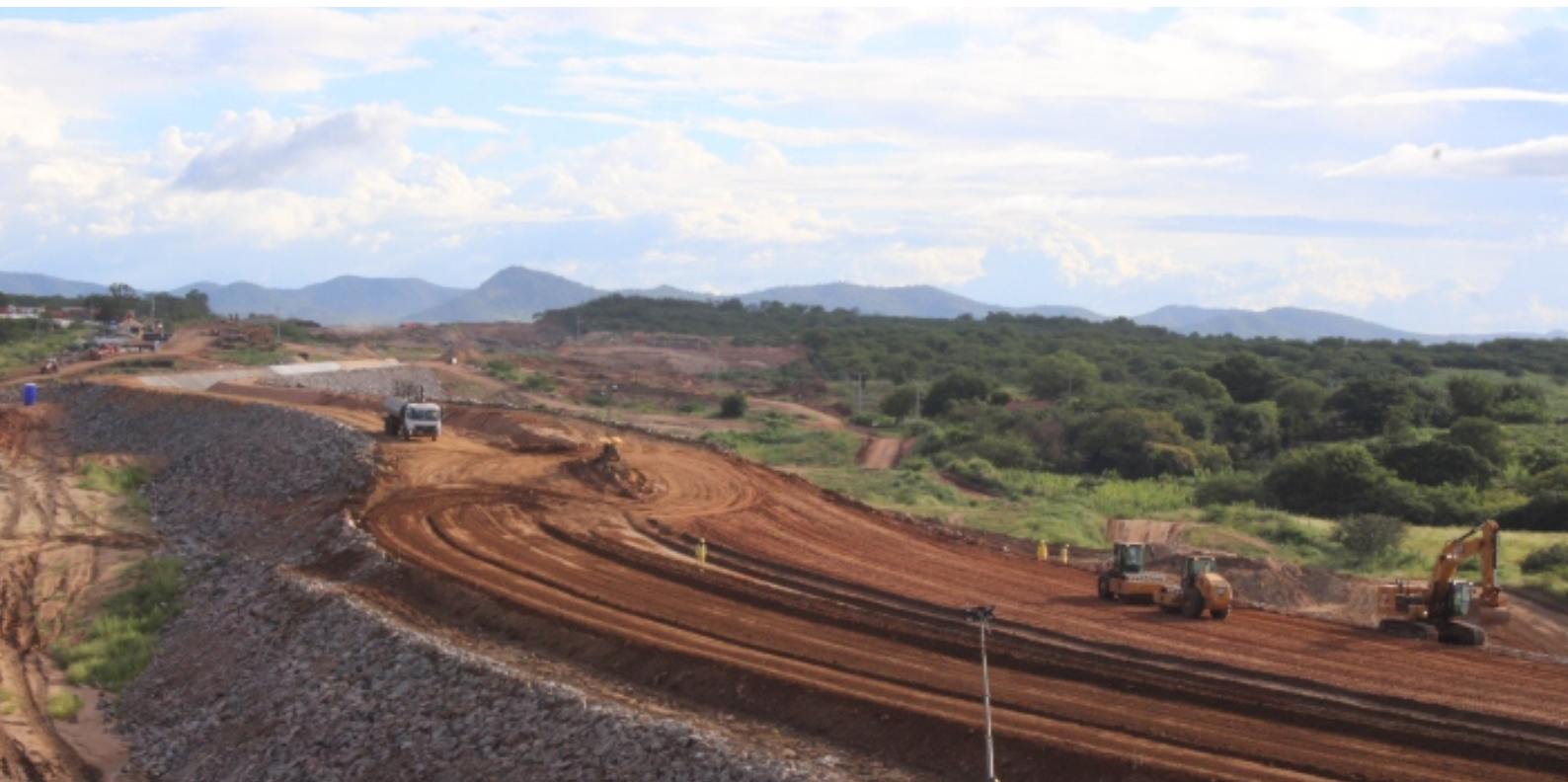
Instalação de enrocamento de talude na área do Reservatório Tambor (WBS 4102). Município de Cachoeira dos Índios/PB.
