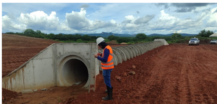
Acompanhamento de construção de bueiro no segmento de canal 14B (WBS 4240) Município de Uiraúna-PB.
