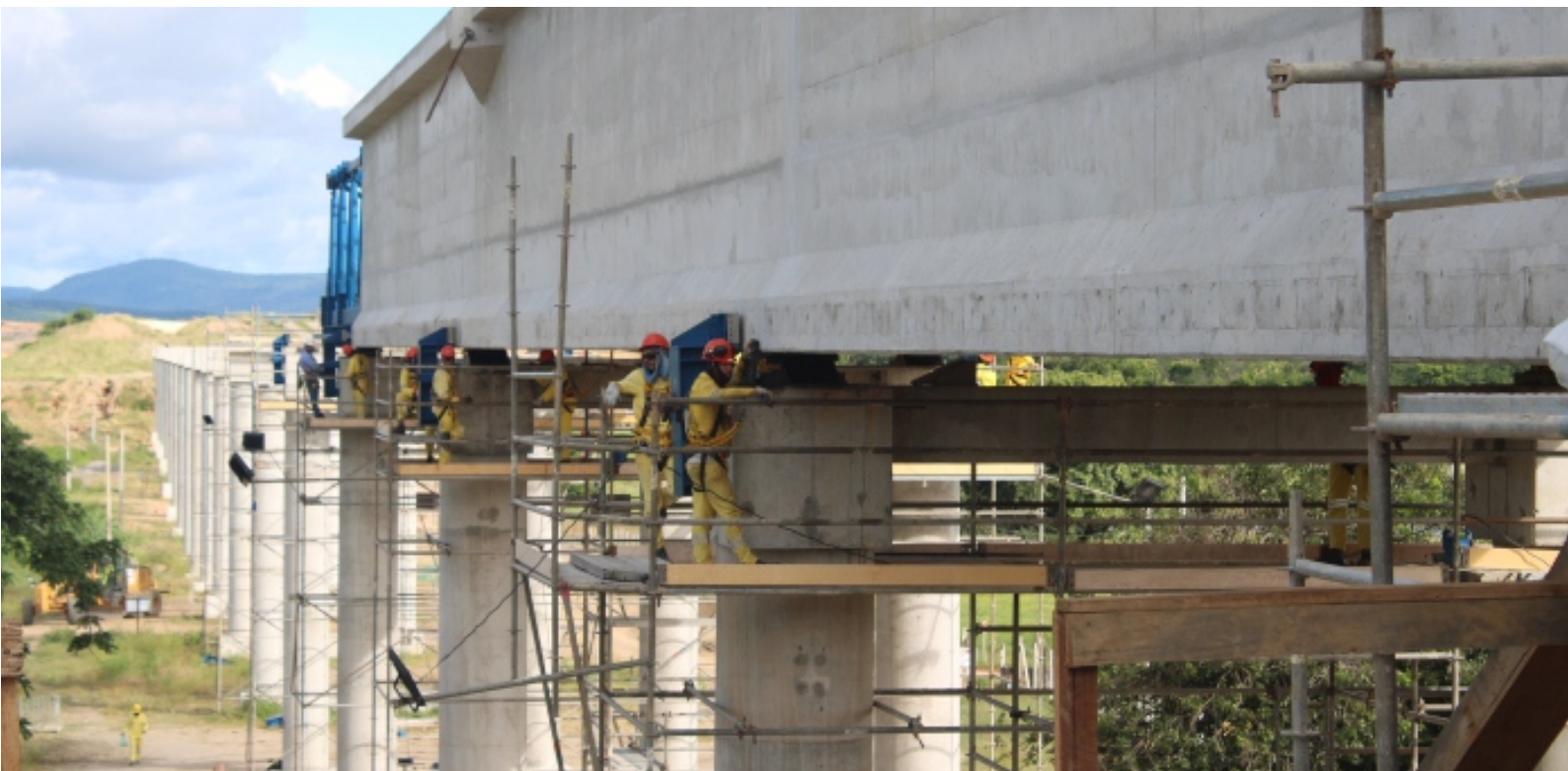
Instalação do Aqüeduto Pitombeira (WBS 4322). Município de Cachoeira dos Índios/PB
