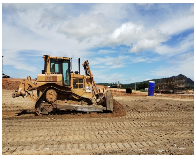
Atividade de reconformação da via de acesso no Canal 6A (WBS 4232). Município de Cachoeira dos Índios/PB
