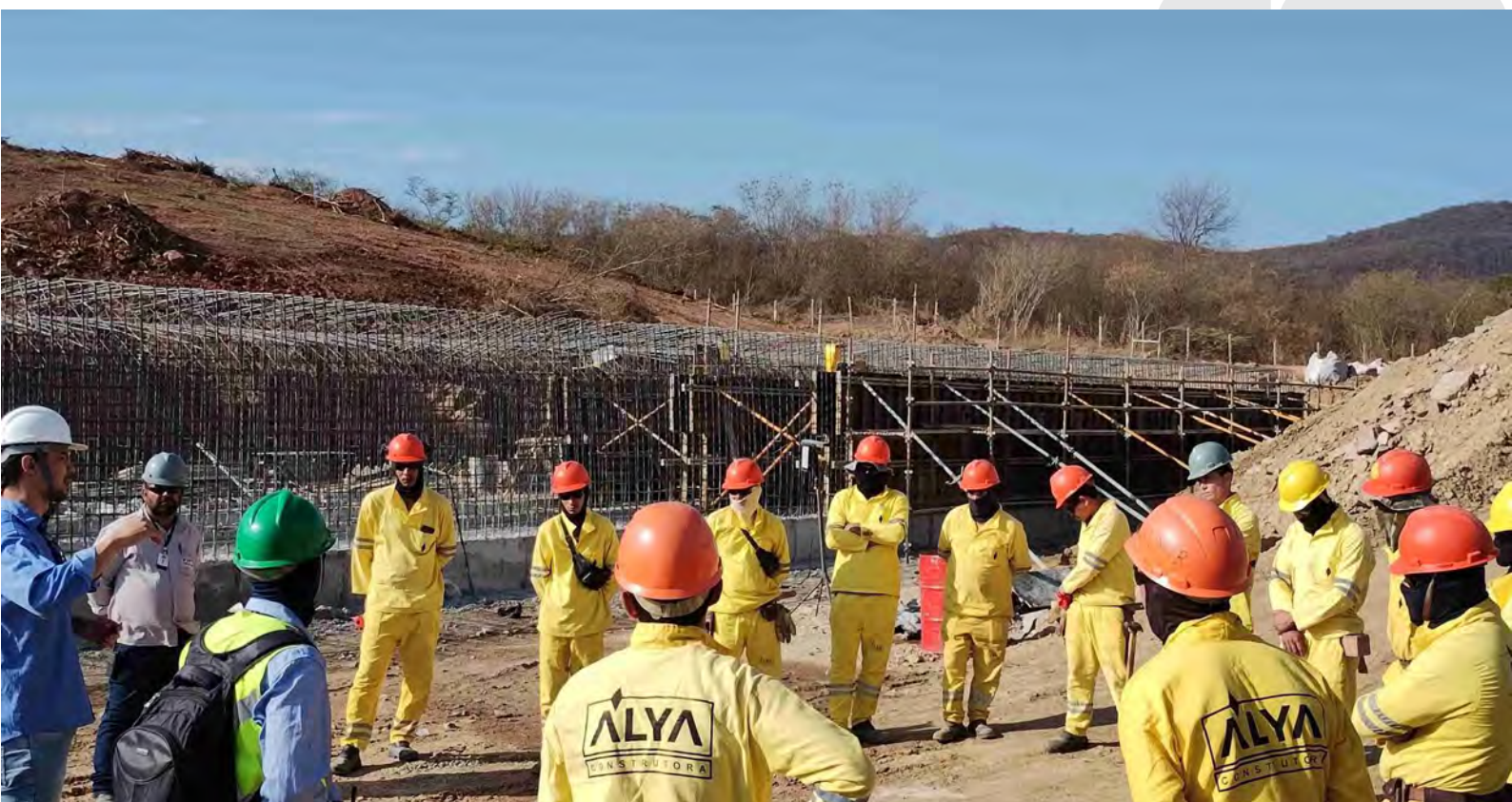
Ação informativa de educação ambiental aos trabalhadores da obra sobre o Dia Internacional de Combate aos Desastres Naturais.
