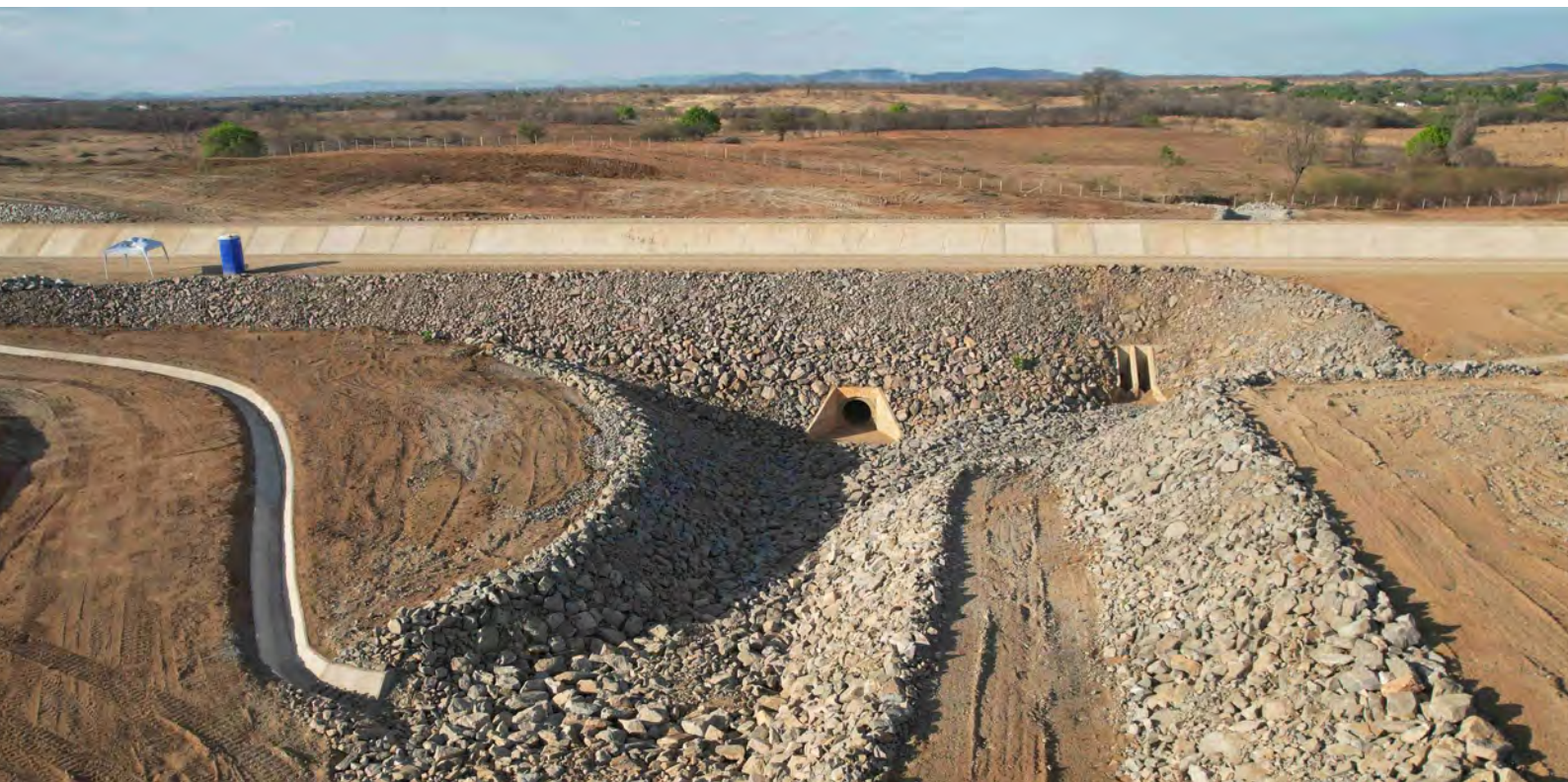
Implantação do sistema de drenagem no Segmento de Canal 05. implantada no Canteiro Central de Obras
