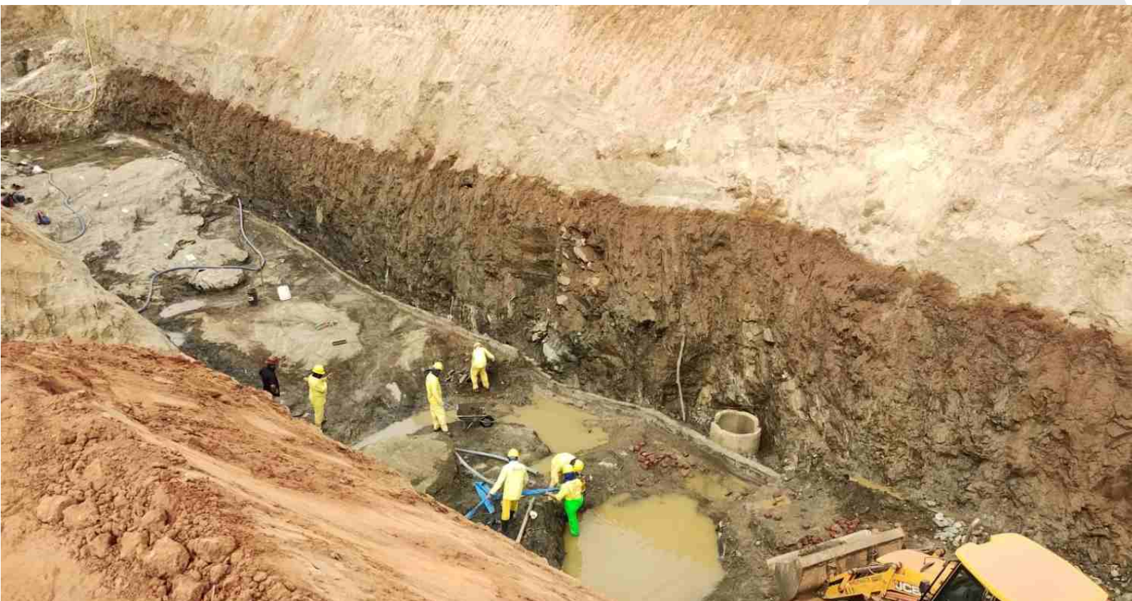
Visita técnica na área da barragem do futuro reservatório Tambor
