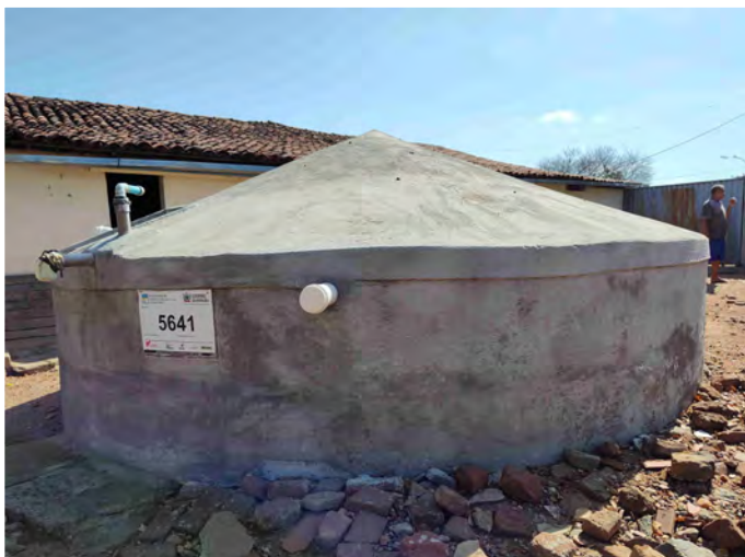
Estrutura de abastecimento (cisterna de captação de água de chuva) identificada no sítio Pau D'Arco, município de Cajazeiras – PB.
