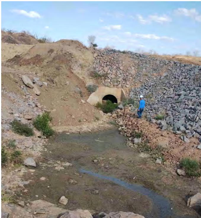
Linha férrea interceptada pelas obras do sifão Lagoa de Dentro – WBS 4377.
