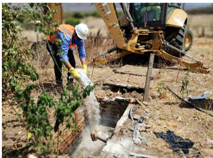
Atividades de desinfecção de fontes contaminantes e remoção das estruturas no Segmento de Canal 13.
