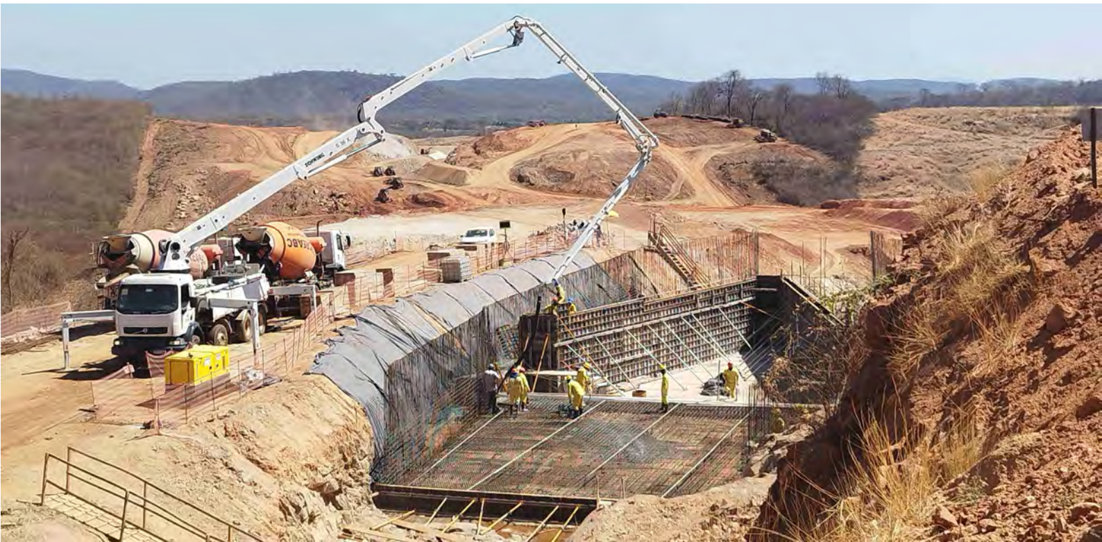
Atividade de lançamento de concreto na estrutura do Rápido Arruído (WBS 4372), município de Cajazeiras - PB.
