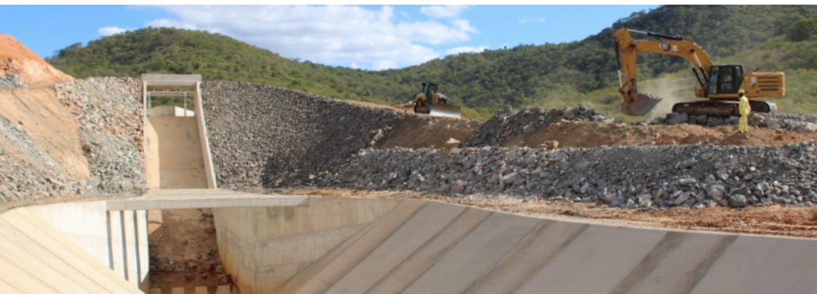
Enrocamento de tabuldes no Rápido Arruído.
