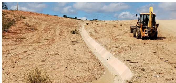
Sistema de drenagem superficial instalada no segmento de canal 2.
