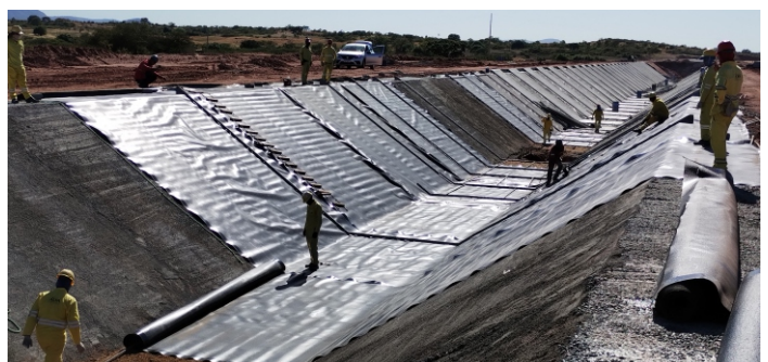
Instalação de geomembrana no segmento de canal 12C.
