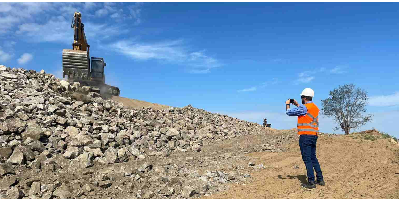
Enrocamento de talude no segmento de canal 7A. Município de Ipaumirim/CE.
