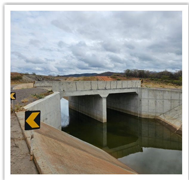
Acesso sobre galeria, construído no segmento do canal 3 – Cajazeiras/PB.
