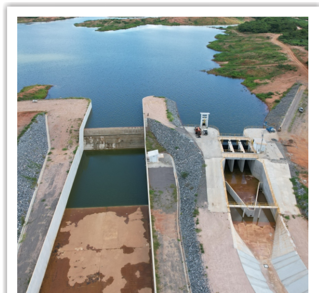
Estrutura de Controle do Reservatório Redondo.
