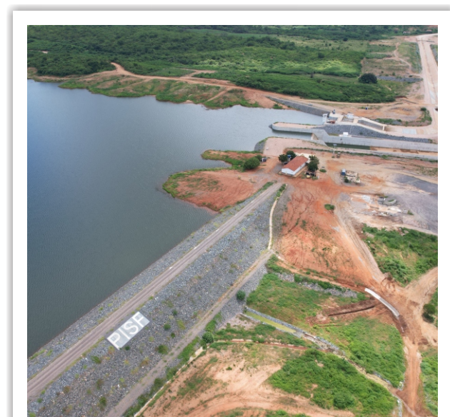
Barramento do Reservatório Redondo.
