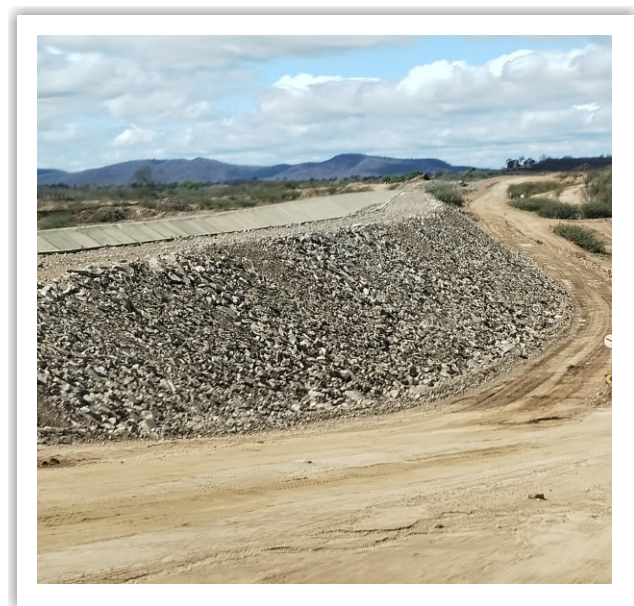
Enrocamento do talude externo do segmento de canal 11, Santa Helena-PB.
