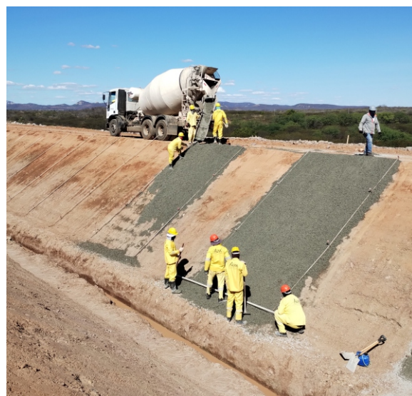
Concretagem do talude interno do segmento canal 14A, Uiraúna-PB.
