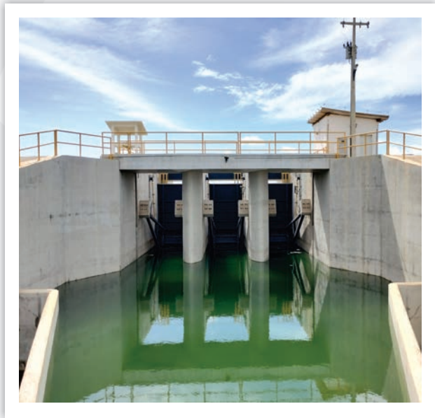
Estrutura de Controle do Reservatório Redondo.
