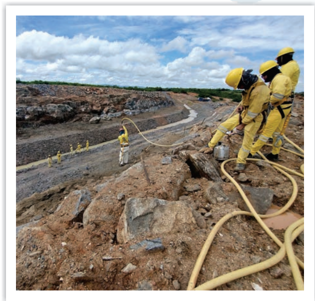
Limpeza de talude realizada no segmento do canal 9.
