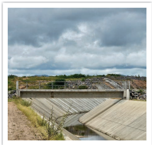
Passarela instalada no segmento do canal 6B.
