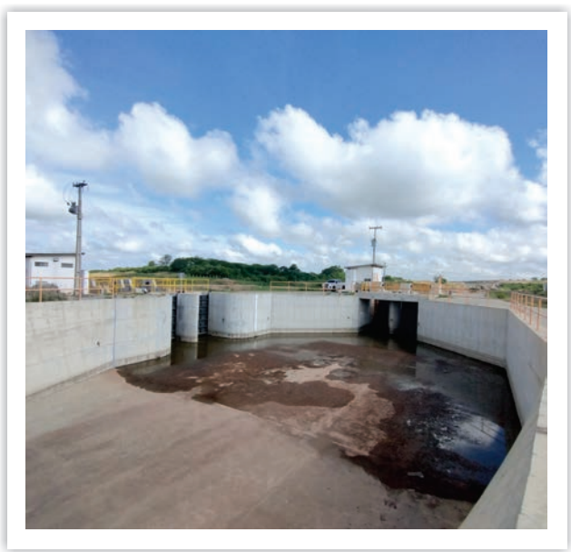
Estrutura de Controle e Derivação do Ramal do Salgado.
