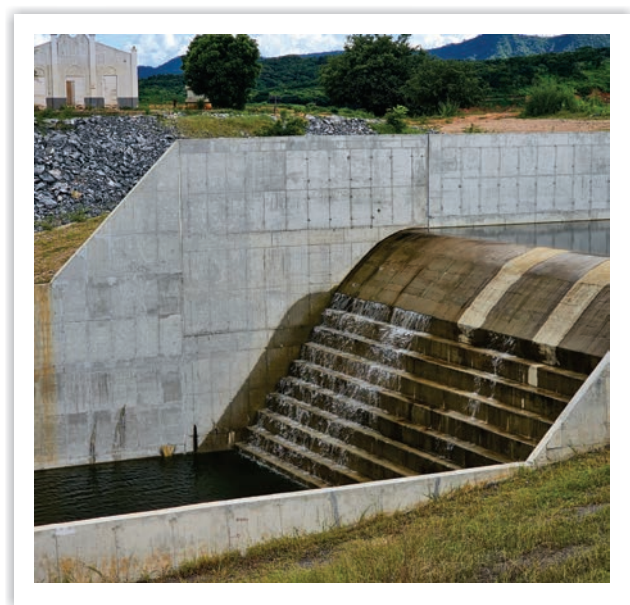
Vertimento de água no reservatório Redondo.
