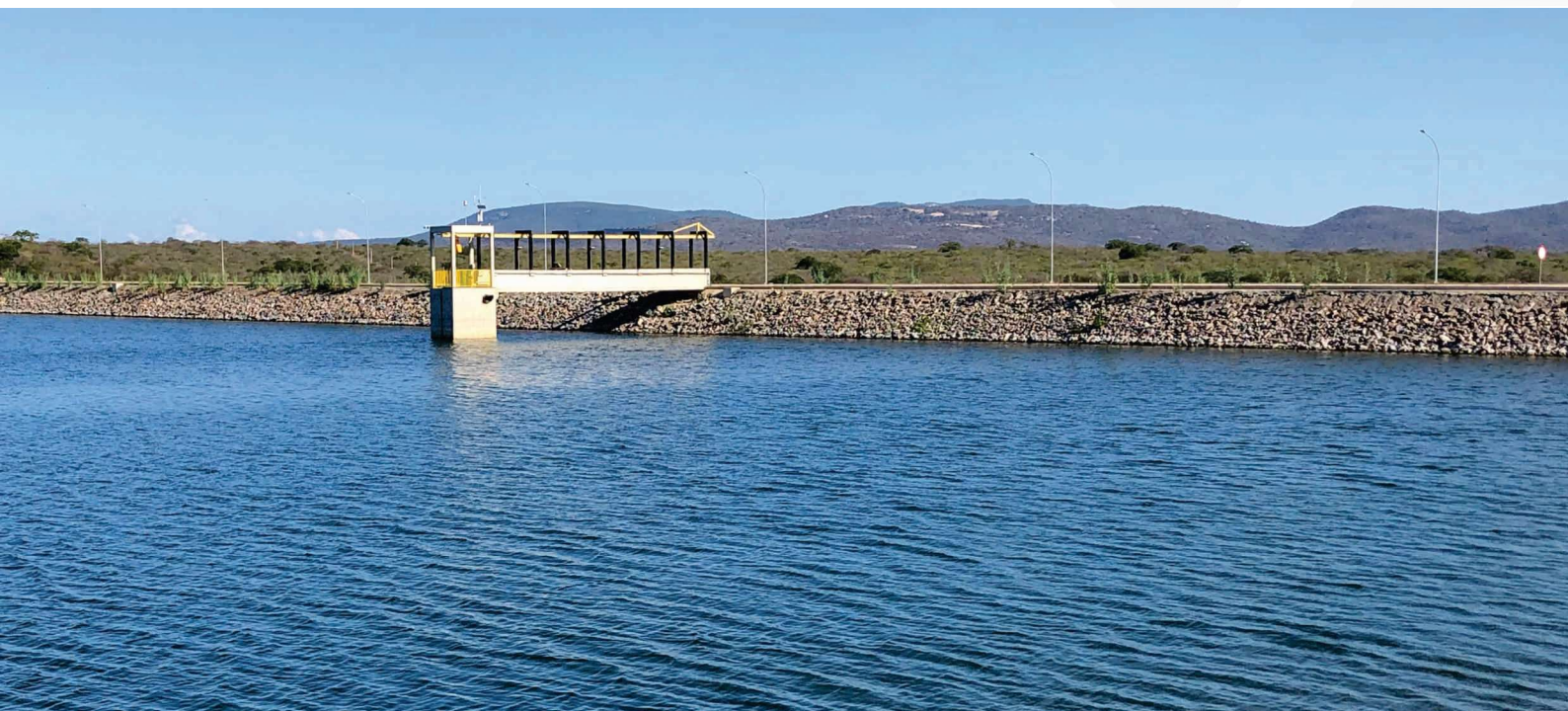
Barragem dos Góis.
