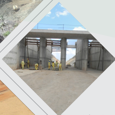
Estrutura de Controle Reservatório Boi I
