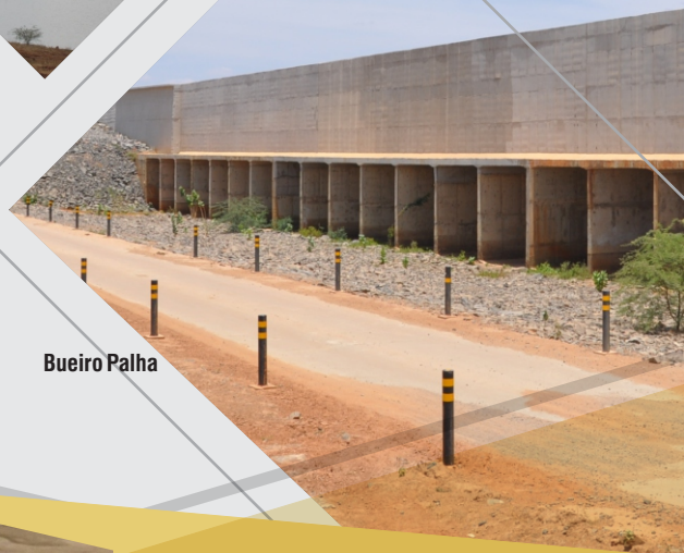
Estrutura de Controle Reservatório Boa Vista
