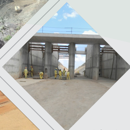
Estrutura de Controle Reservatório Boi I
