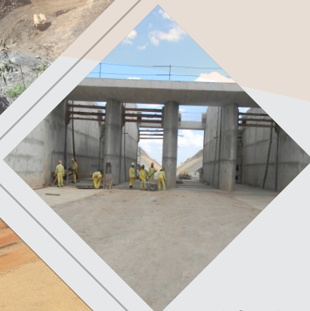
Estrutura de Controle Reservatório Boi I
