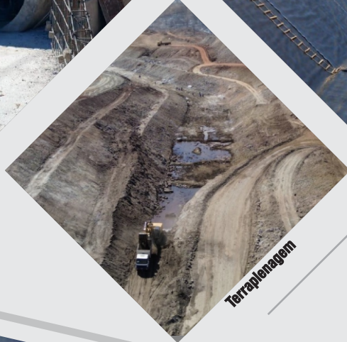
Terraplenagem de Bueiros
