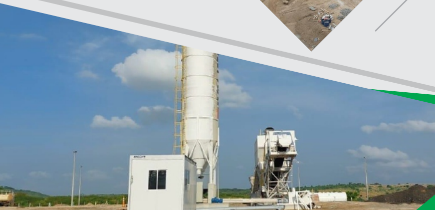
Canteiro de obra - Central de Concreto
