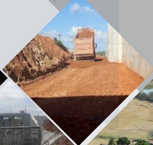
Execução de Aterro Compactado
