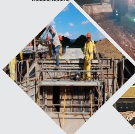
Execução de Bueiro
