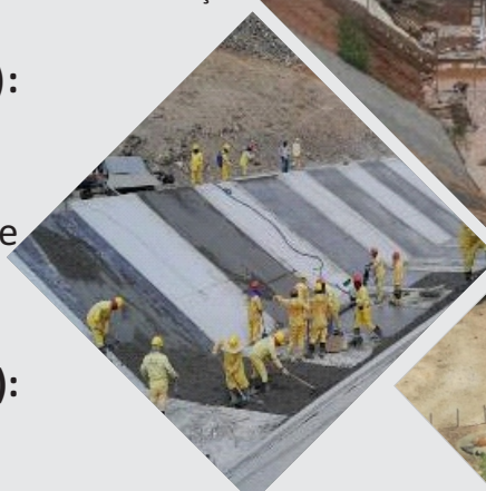
Execução de Geomembrana e placas de proteção
