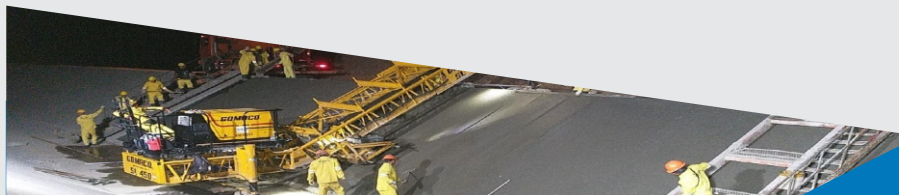
Execução de Placas de Concreto (Noturno)
