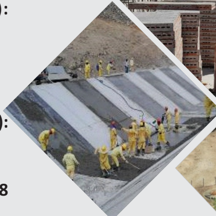
Execução de Geomembrana e placas de proteção
