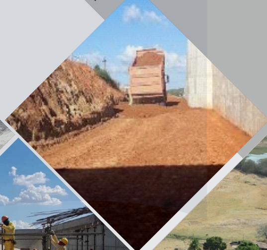
Execução de Aterro Compactado
