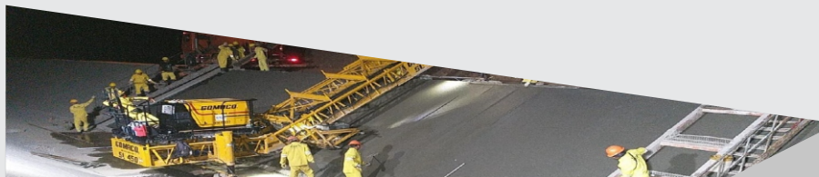
Execução de Placas de Concreto (Noturno)
