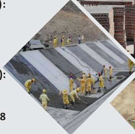
Execução de Geomembrana e placas de proteção
