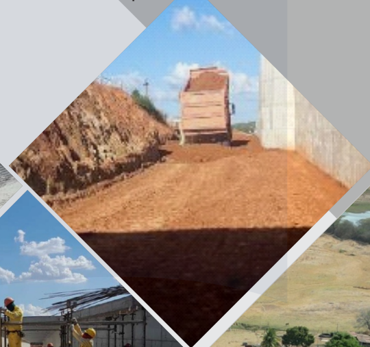
Execução de Aterro Compactado
