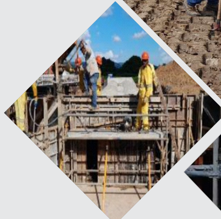
Execução de Bueiro
