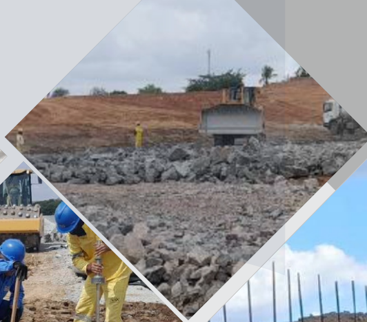
Execução de enrocamento compactado
