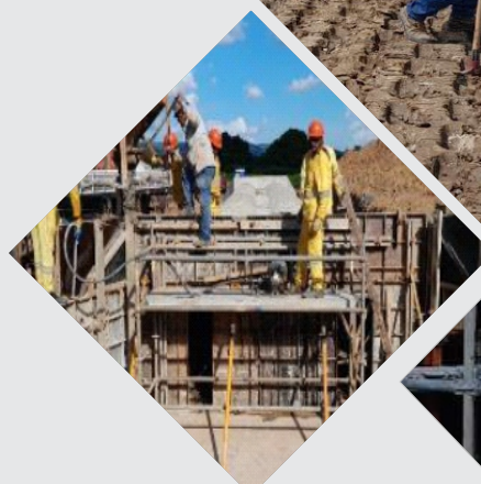
Execução de Bueiro
