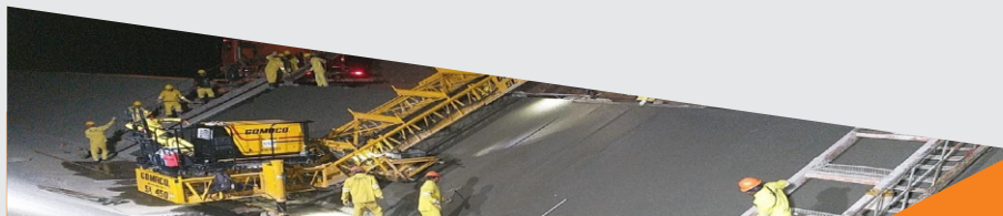
Execução de Placas de Concreto (Noturno)
