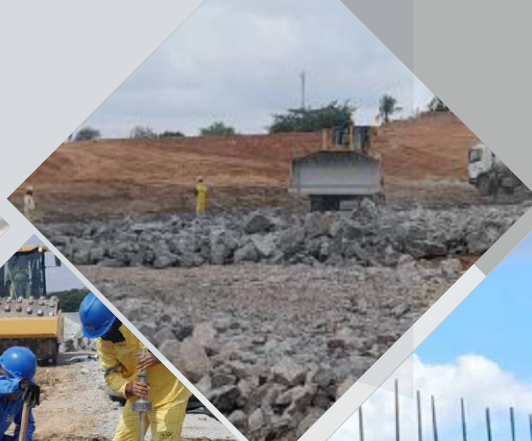
Execução de enrocamento compactado
