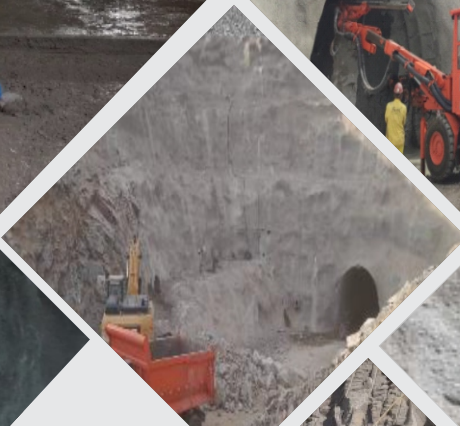
Túnel Major Sales: Emboque, remoção do material de 3ª.
