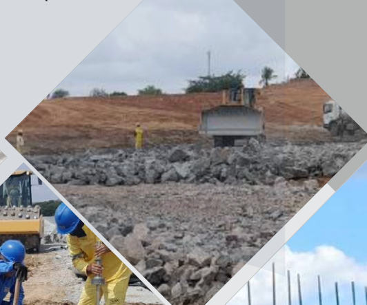
Execução de enrocamento compactado
