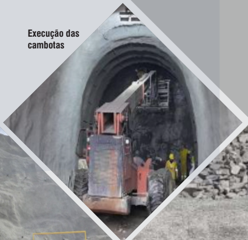
Perfuração para desmonte de rocha e abertura do emboque.
