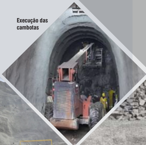
Perfuração para desmonte de rocha e abertura do emboque.
