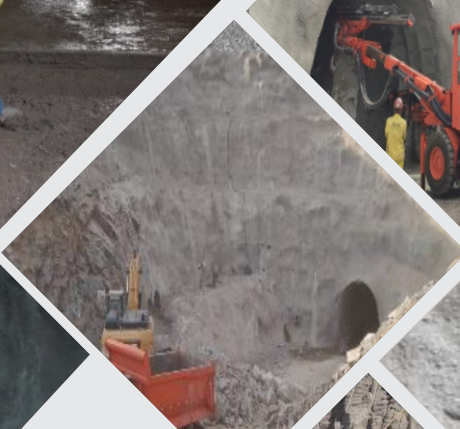
Túnel Major Sales: Emboque, remoção do material de 3ª.
