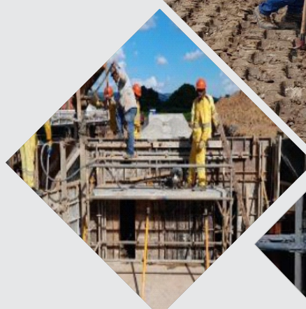
Execução de Bueiro
