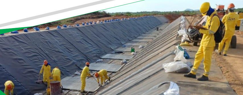
Canal 8: Execução de geomembrana
