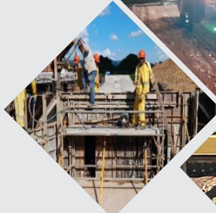
Execução de Bueiro
