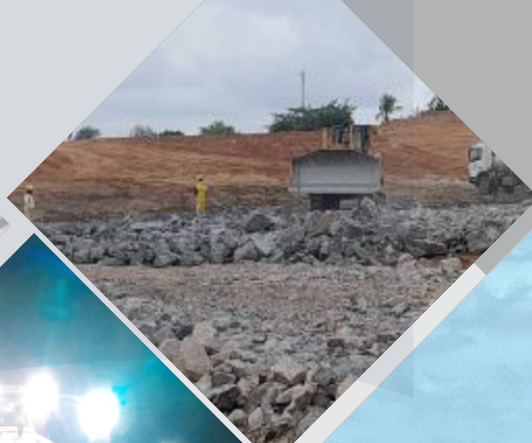
Execução de enrocamento compactado
