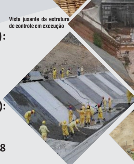
Execução de Geomembrana e placas de proteção
