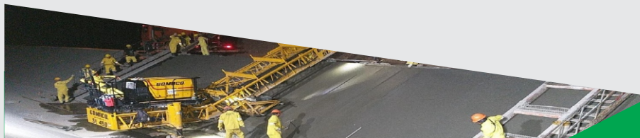
Execução de Placas de Concreto (Noturno)
