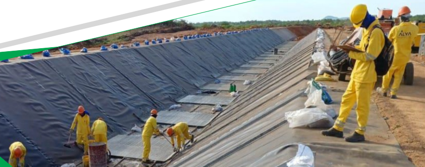
Canal 8: Execução de geomembrana
