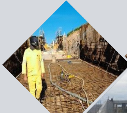
Execução de forma de armação
