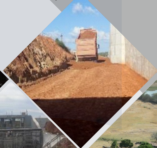
Execução de Aterro Compactado
