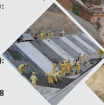
Execução de Geomembrana e placas de proteção
