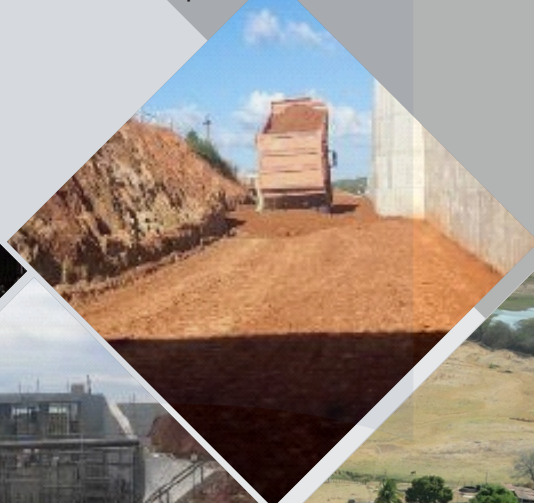
Execução de Aterro Compactado
