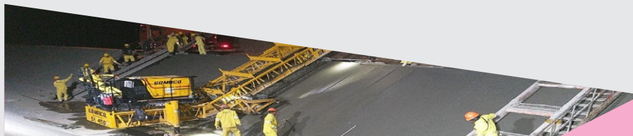
Execução de Placas de Concreto (Noturno)
