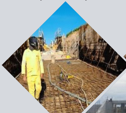
Execução de forma de armação
