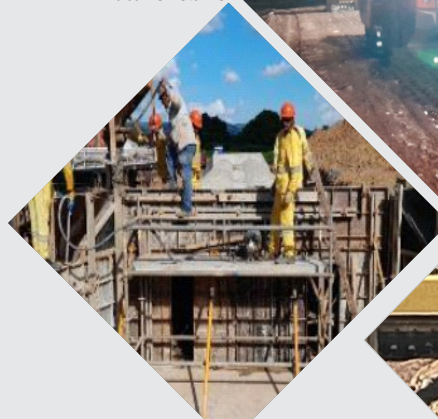
Execução de Bueiro
