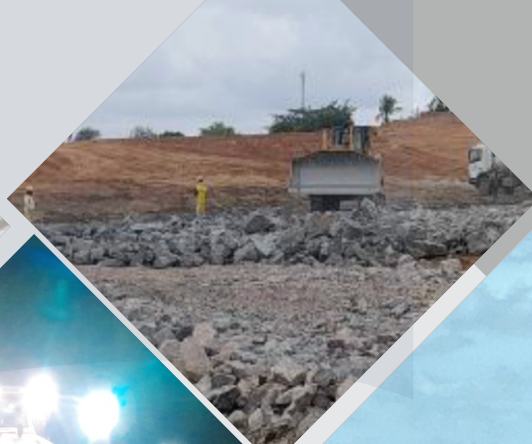
Execução de enrocamento compactado
