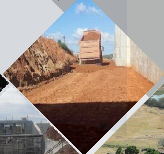
Execução de Aterro Compactado
