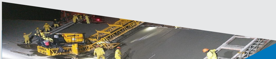
Execução de Placas de Concreto (Noturno)
