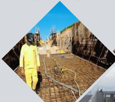
Execução de forma de armação
