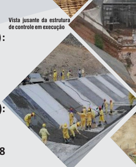
Execução de Geomembrana e placas de proteção
