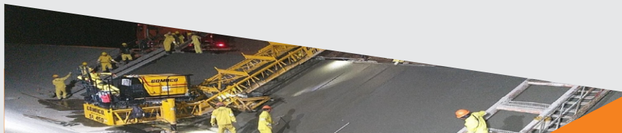
Execução de Placas de Concreto (Noturno)
