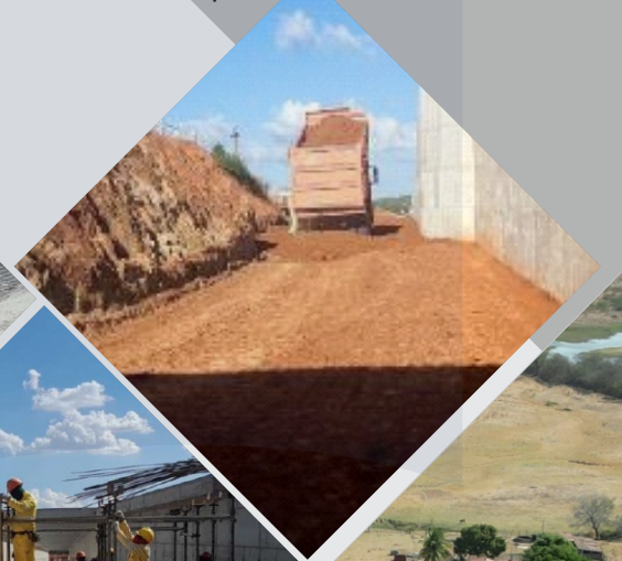
Execução de Aterro Compactado
