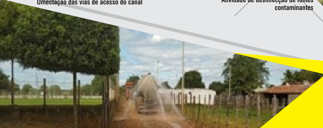
Umectação das vias de acesso do canal
