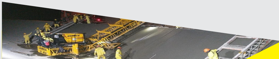
Execução de Placas de Concreto (Noturno)
