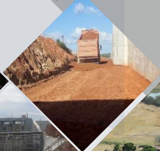
Execução de Aterro Compactado
