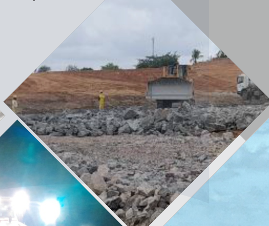
Execução de enrocamento compactado
