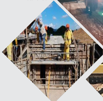
Execução de Bueiro
