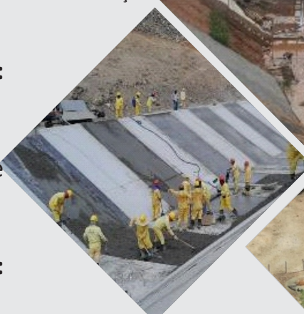
Execução de Geomembrana e placas de proteção
